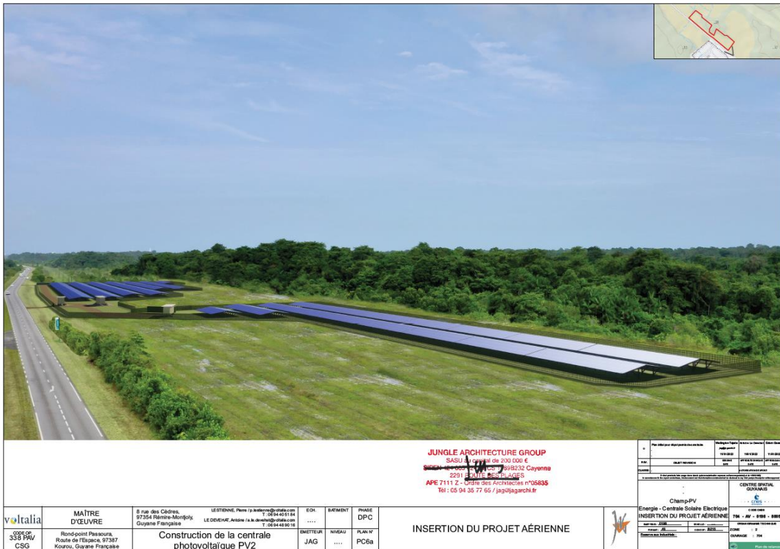
Figure 1 : Photomontage de l'insertion aérienne du projet (source : Permis de construire 12/2022)
